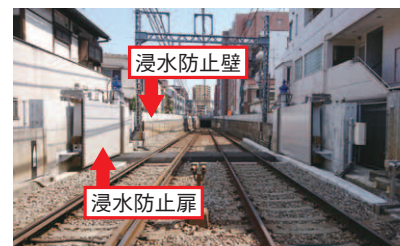
▲大鳥居駅トンネル入口(京急蒲田方)
