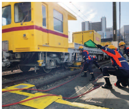
▲異常時復旧訓練
