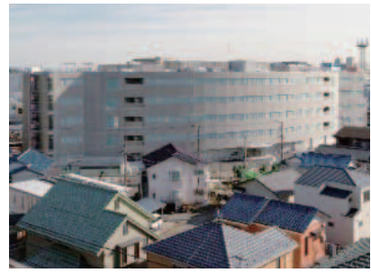
▲金沢文庫現業事務所 外観
