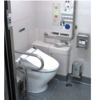
▲バリアフリー対応洋式トイレ(2号車)
