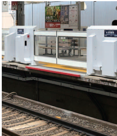
▲京急鶴見駅上りホーム
