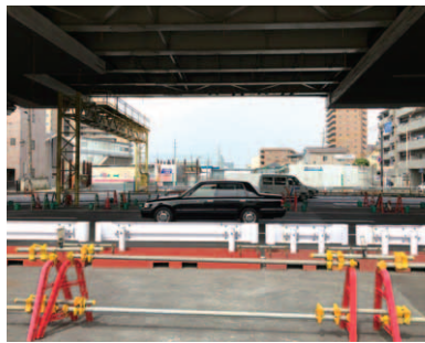
▲旧産業道路第1踏切道付近
